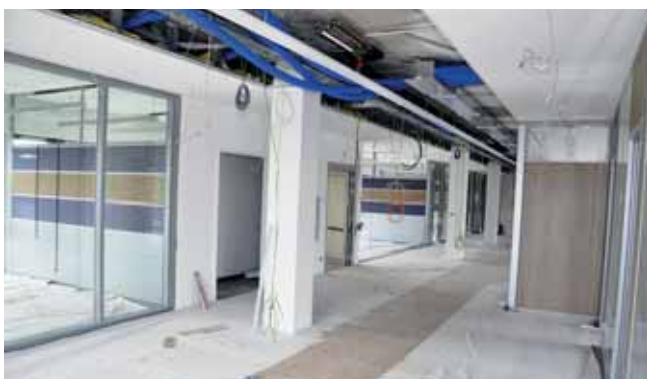
Innenausbau: Die Büros wurden mit Systemtrennwänden errichtet, um einen möglichst hohen Grad an Flexibilität zu gewinnen. So können sie mit wenig Aufwand umgestaltet und an neue Entwicklungen angepasst werden.
